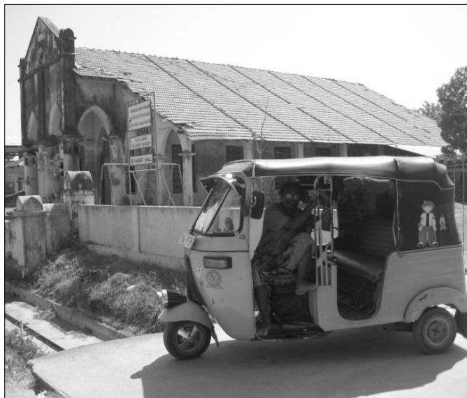
Viele Kirchen im Norden Sri Lankas sind nach Krieg und Tsunami renovierungsbedürftig wie diese Methodistische Kirche in Point Pedro auf der Jaffna-Halbinsel.
